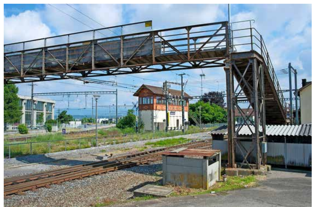
Die Passerelle bildet mit dem alten Stellwerk ein eisenbahnhistorisch einmaliges Ensemble.
