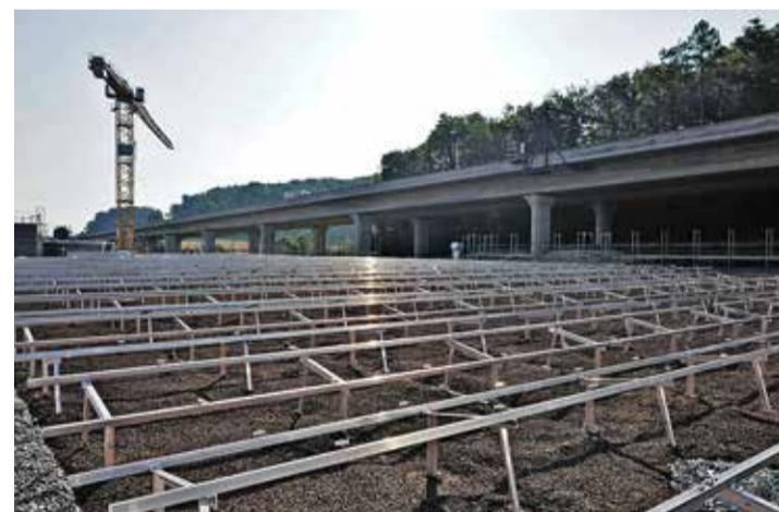
Die Unterkonstruktion für die Fotovoltaik-Anlage neben der A1.
