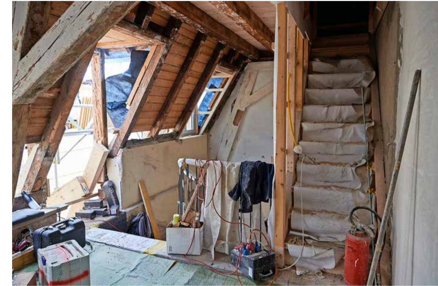
Noch ist das Hotel Bahnhof eine grosse Baustelle. Im April 2021 soll der Sozialdienst einziehen können.
